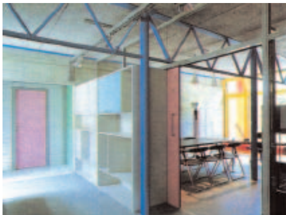
Elementi della struttura metallica lasciati in vista in un asilo a Valency in Svizzera.
