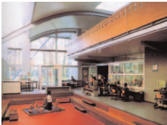
Le murature interne realizzate con blocchi di cemento lasciati in vista, i pavimenti in materiale plastico e i gradoni in legno in una scuola a Venlo in Olanda.
